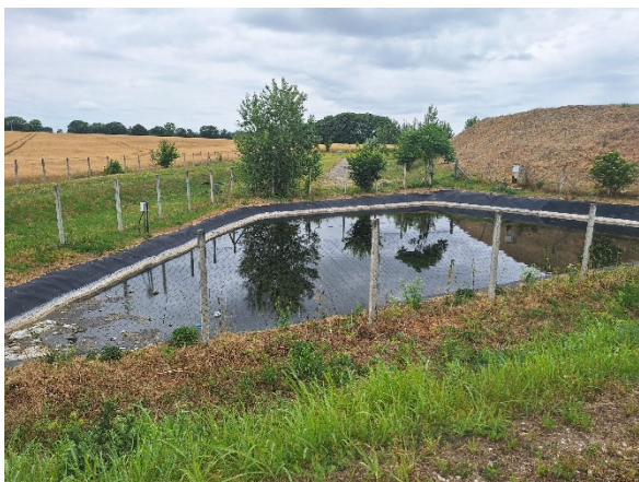
Rekultivált hulladéklerakó csurgalékvíz tározóval Rekultivált szeméttelap és hulladékudvar
